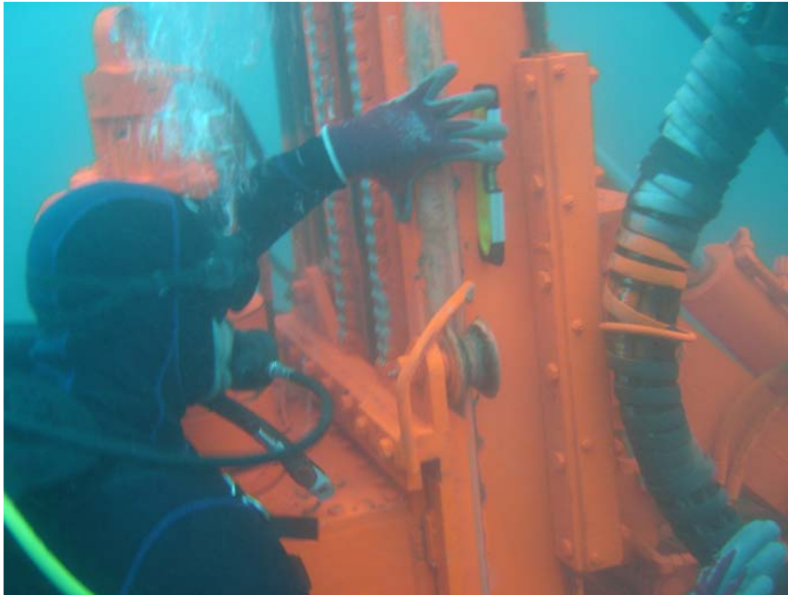
Colocación y nivelado de la Sd7
